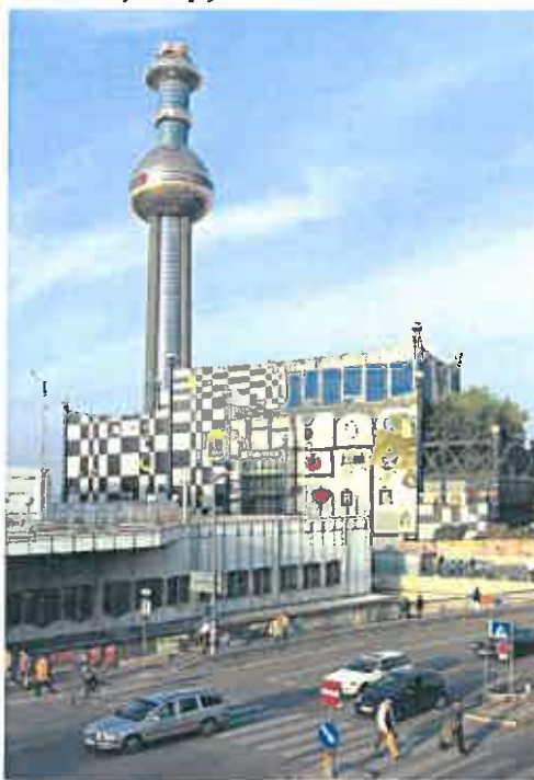
Władze miejskie Tarnowa jako argument za budową spalarni śmieci podają ekologiczną spalarnię i elektrociepłownię Spittelau w centrum Wiednia, na której w części miałyby być wzorowana ta, którą planuje się na Piaskówce
