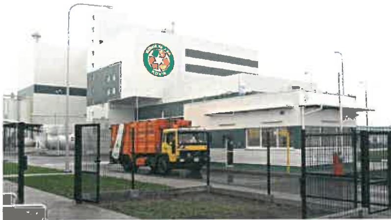
W 75-tysięcznym Koninie od trzech lat pracuje nowoczesny zakład termicznego unieszkodliwiania odpadów komunalnych. Podobny może powstać w Tarnowie
